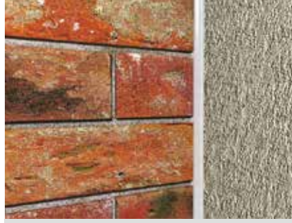
İnşaat derzi uygulaması
