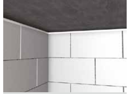
İnşaat derzi uygulaması
