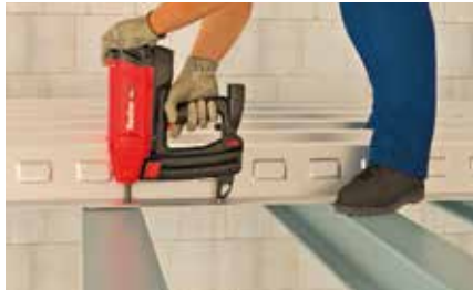
Kompozit döşeme saclarının çelik kirişlere geçici sabitlenmesi
