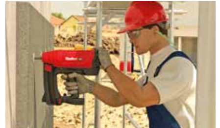
TFD mantolama dübelleri sayesinde FGC 100 ile ısı yalıtım levhalarını hızlı ve zahmetsizce sabitlenir
