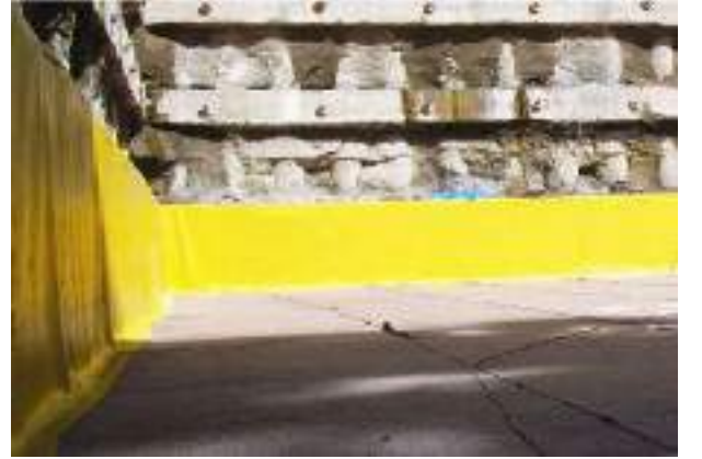
Betonarme Perde Yalıtımı
