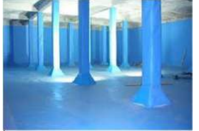
İçme Suyu Deposu Yalıtımı
