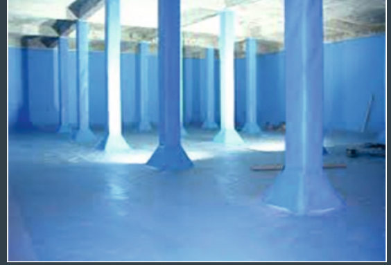
İçme Suyu Deposu Yalıtımı
