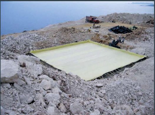
Grobeton Üzeri Su Yalıtımı
