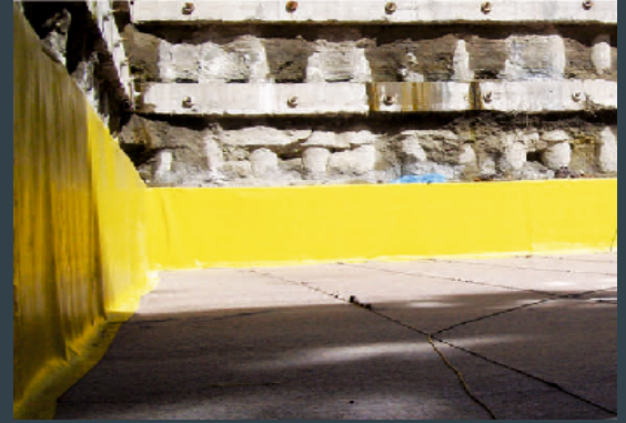
Betonarme Perde Yalıtımı
