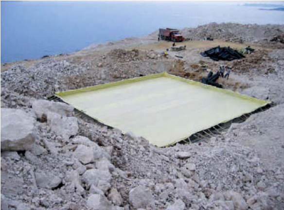
Grobeton Üzeri Su Yalıtımı
