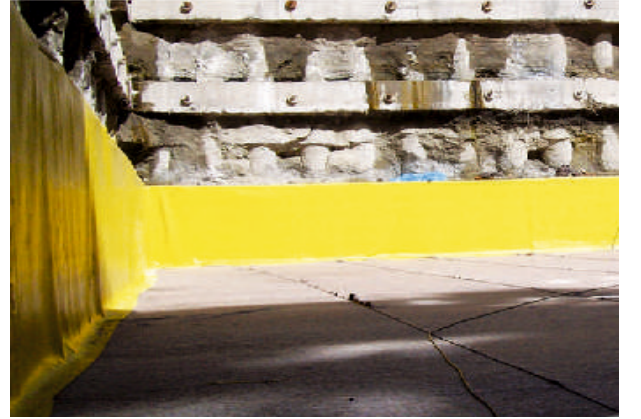
Betonarme Perde Yalıtımı
