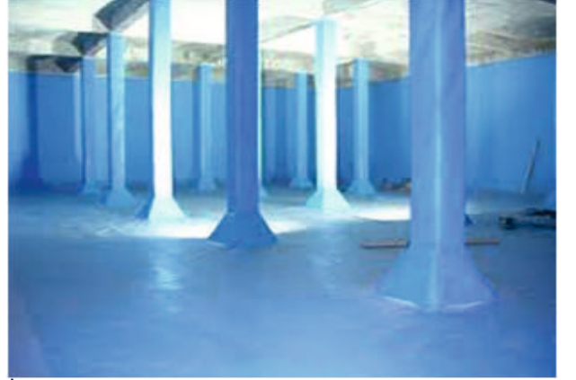
İçme Suyu Deposu Yalıtımı
