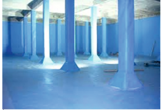
İçme Suyu Deposu Yalıtımı
