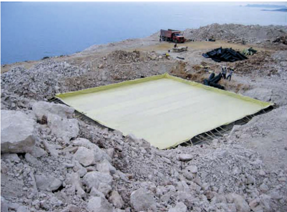
Grobeton Üzeri Su Yalıtımı
