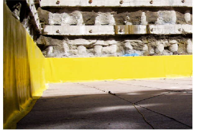
Betonarme Perde Yalıtımı
