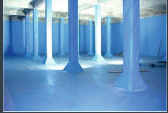
İçme Suyu Deposu Yalıtımı
