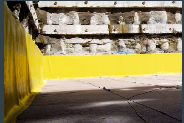
Betonarme Perde Yalıtımı
